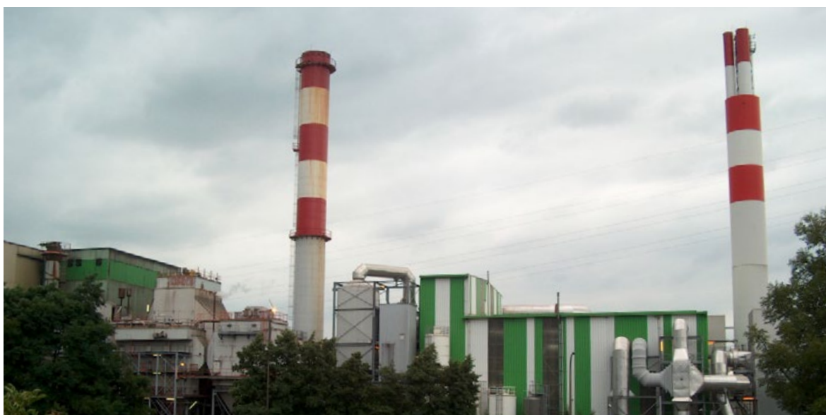
UNITÉ DE VALORISATION ÉNERGÉTIQUE VUE DE LA COMMUNE D'AISEAU-PRESLES. ON PEUT VOIR LES ENSEMBLES FOURS-CHAUDIÈRES (À GAUCHE DE L'IMAGE) AINSI QUE LE TRAITEMENT HUMIDE DES FUMÉES (À DROITE DE L'IMAGE).
