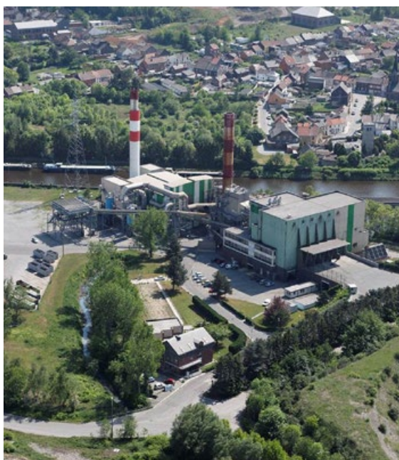
VUE AÉRIENNE DE L'UNITÉ DE VALORISATION ÉNERGÉTIQUE.
