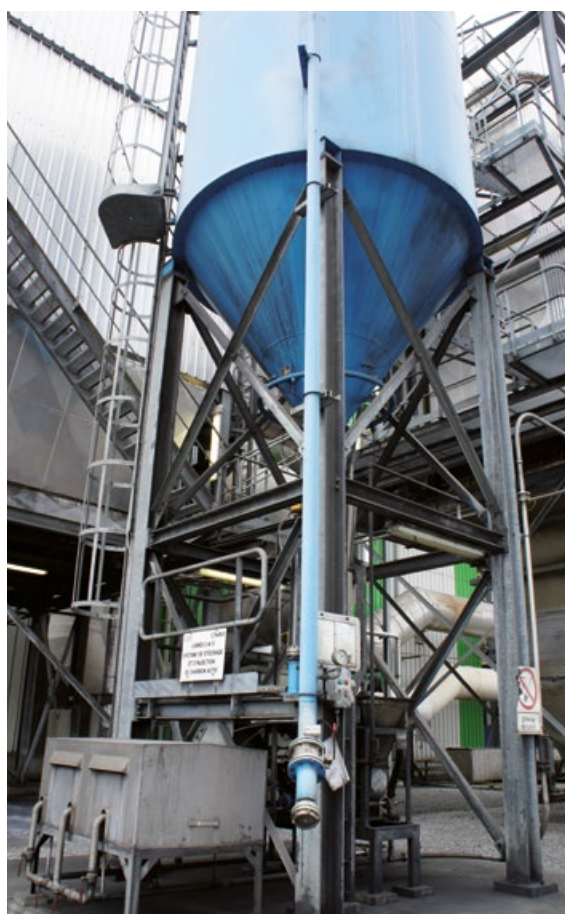
SILO DE CHARBON ACTIF : LE CHARBON ACTIF PERMET LE TRAITEMENT DES DIOXINES CONTENUES DANS LES FUMÉES.
