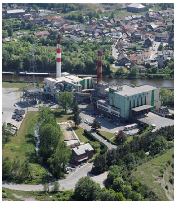
VUE AÉRIENNE DE L'UNITÉ DE VALORISATION ÉNERGÉTIQUE.
